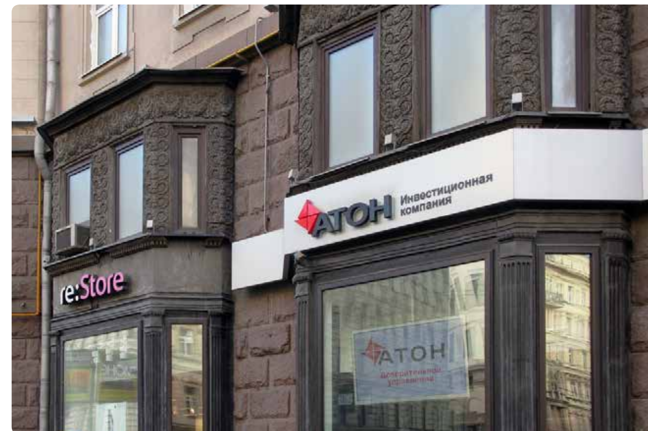
Вывески без подложки (слева) и с подложкой. Вывеска без подложки меньше портит вид здания, поэтому является более предпочтительной
