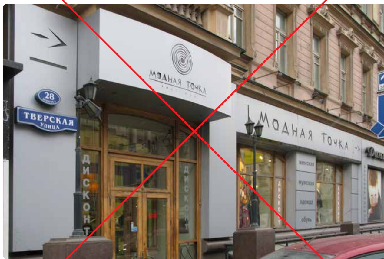
Весь первый этаж здания закрыт фальшфасадом
