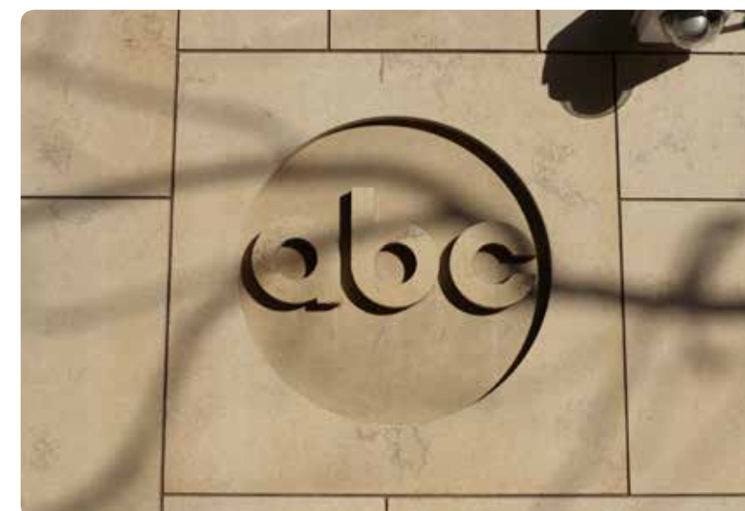
Вывеска является частью фасада
