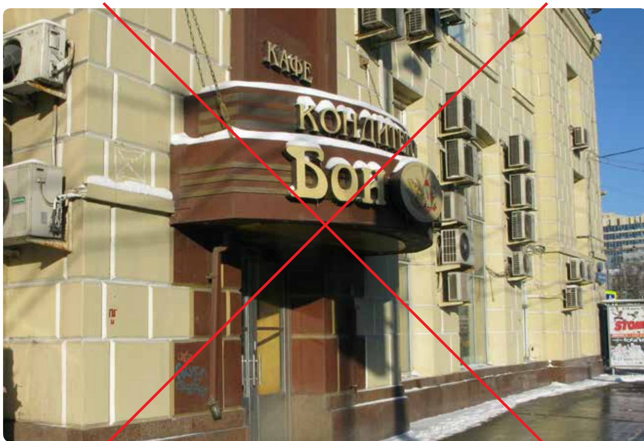
Массивная конструкция никак не сочетается с фасадом
