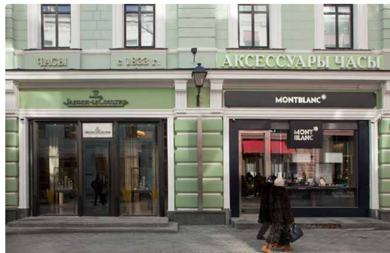
Вывеска на фризе слева меньше влияет на архитектурный облик здания и поэтому является более удачной
