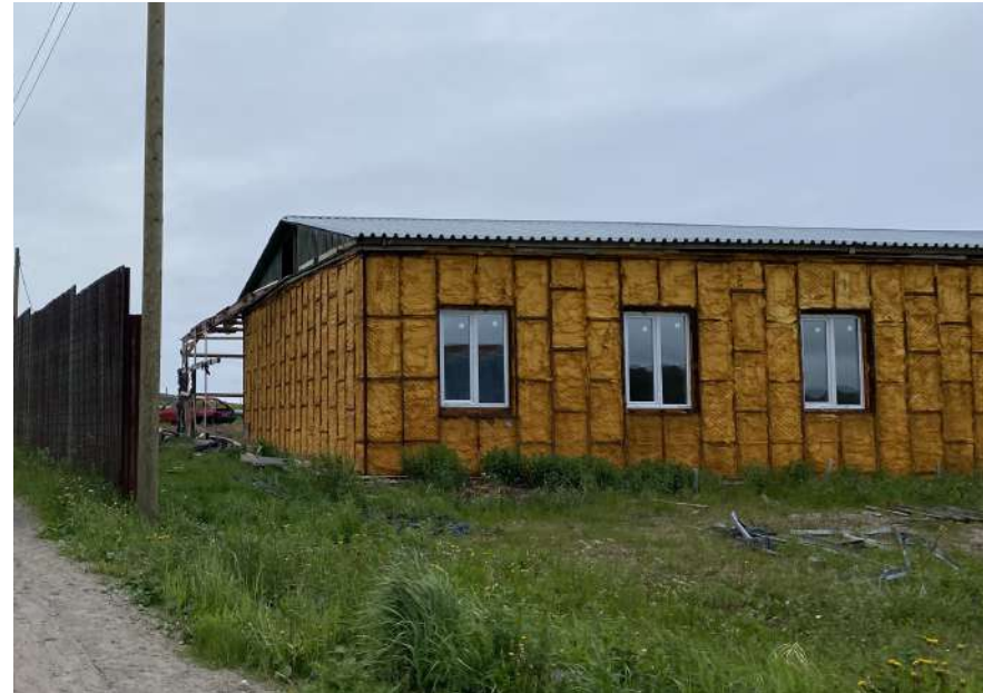
Плохо. На фасаде отсутствуют облицовочные материалы
