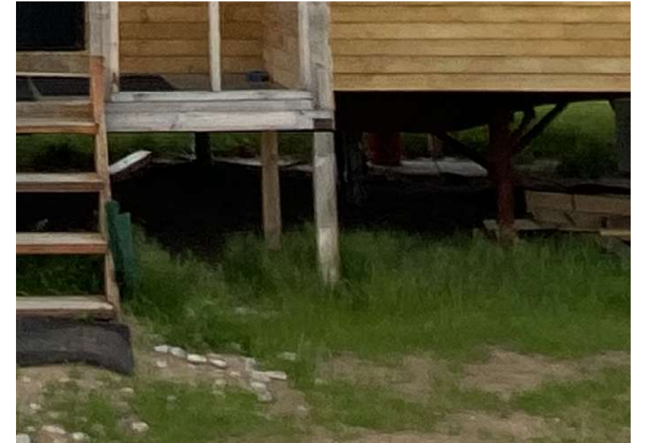
Плохо. Пространство под зданием открыто. Цоколь отсутствует
